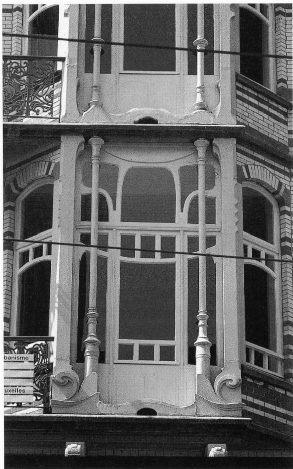
De Jaerlaan 9. Architect Strauven had een voorliefde voor ijzersmeedwerk, zoals blijkt uit de zeer kunstige borstweringen en de in het erkerraam ingewerkte zuiltjes. De invloed van zijn leermeester V. Horta is duidelijk merkbaar.
